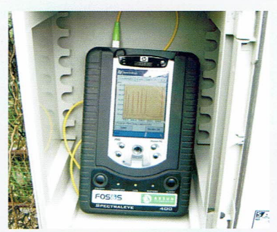
Die Verformungen werden mit dem Geodetect System laufend überwacht - einfach und kostengünstig!
