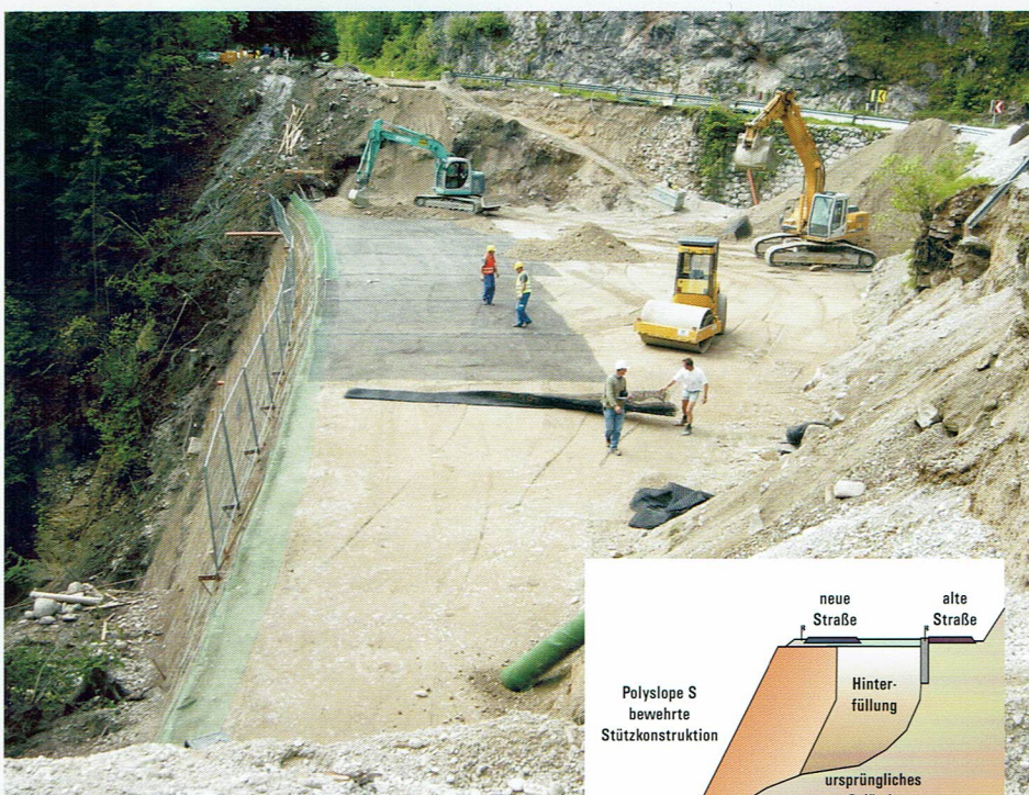
Geringer Geräte- und Personalaufwand und damit geringe Baukosten zeichnen das Polyslope S System aus.
