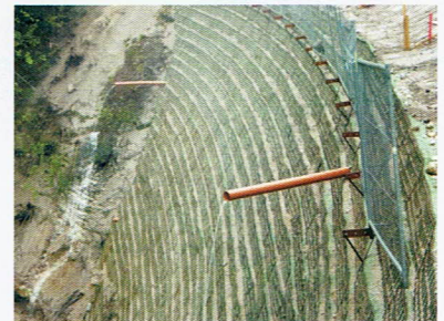
Drainage zur Ableitung drückender Hangwässer
